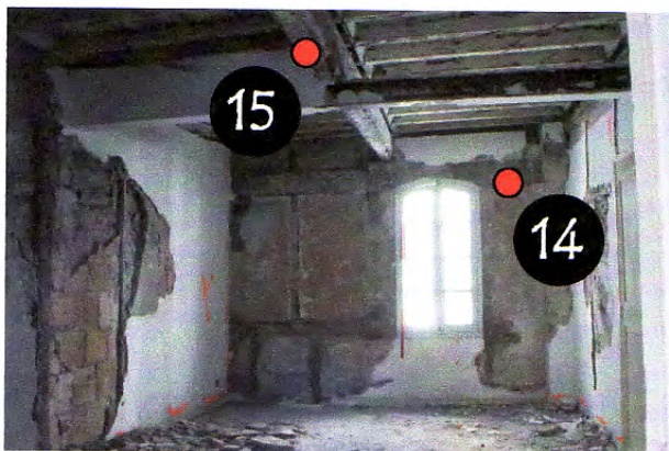
Echantillons n°14 et 15 (carottes) Salle 45D3 : Pan de bois mur Ouest et plafond (poutre porteuse)
