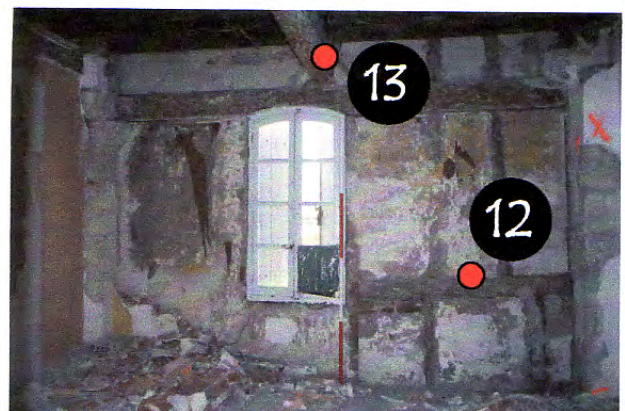
Echantillons n°12 et 13 (carottes) Salle 45D1 : Pan de bois mur Ouest et plafond (poutre porteuse)
