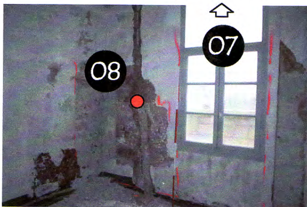
Echantillons n°07 et 08 Salle 45P4 - Pan de bois (écharpe) et Plafond (poutre porteuse)
