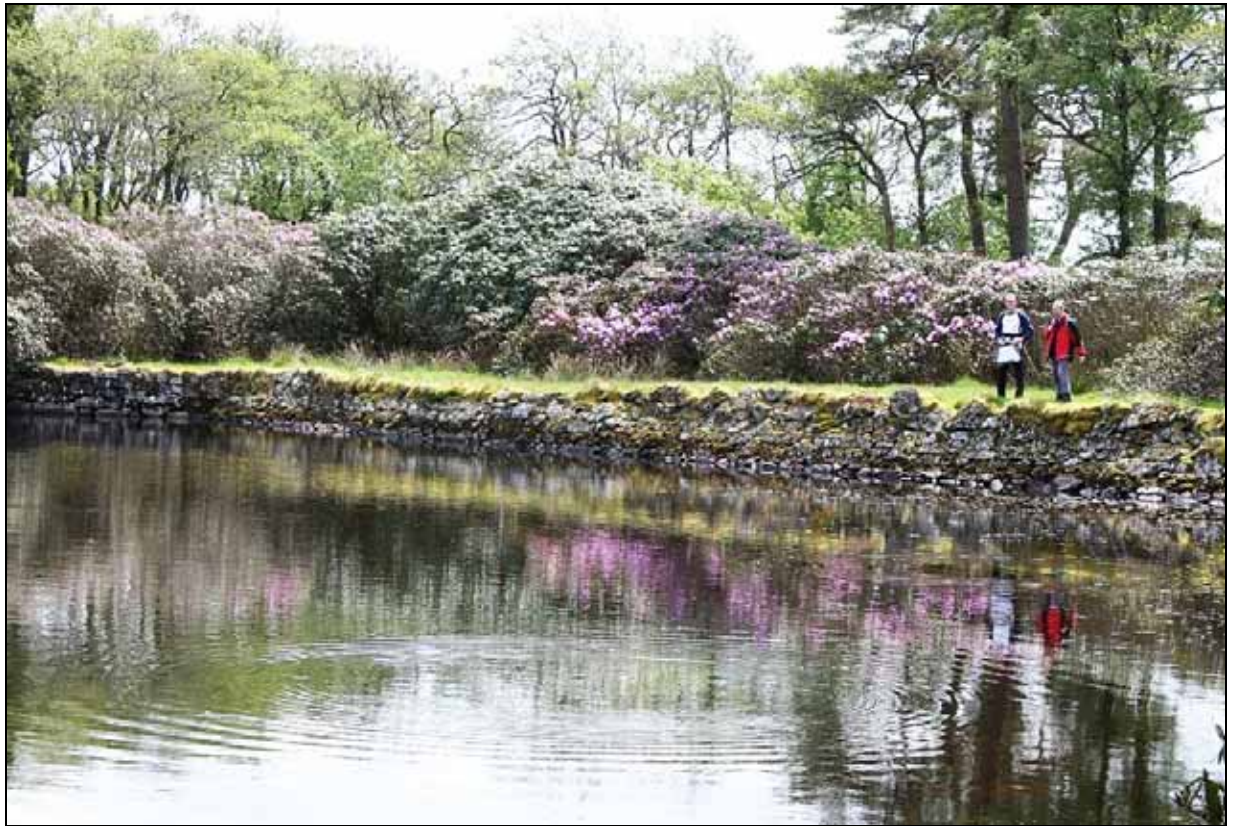
Plate 17: Llyn Maen Bras, Dam (NMR 519287)
