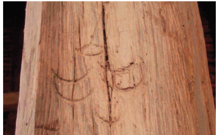
Plate 19: Fleur de Lis carpenters mark
