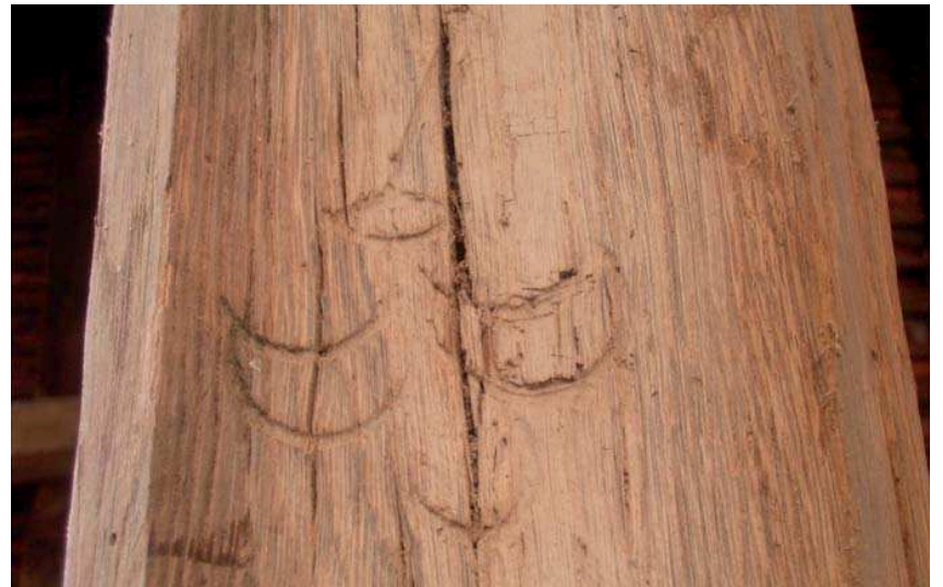
Plate 19: Fleur de Lis carpenters mark
