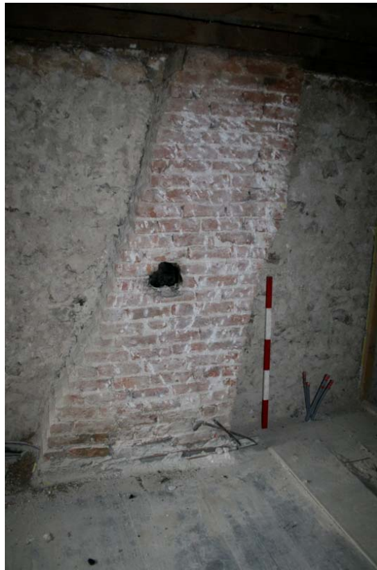
Plate 17: Raking chimney flue, Room F1
