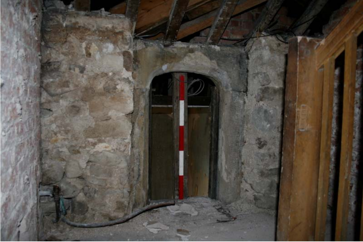
Plate 15: Original stair window, Room F1
