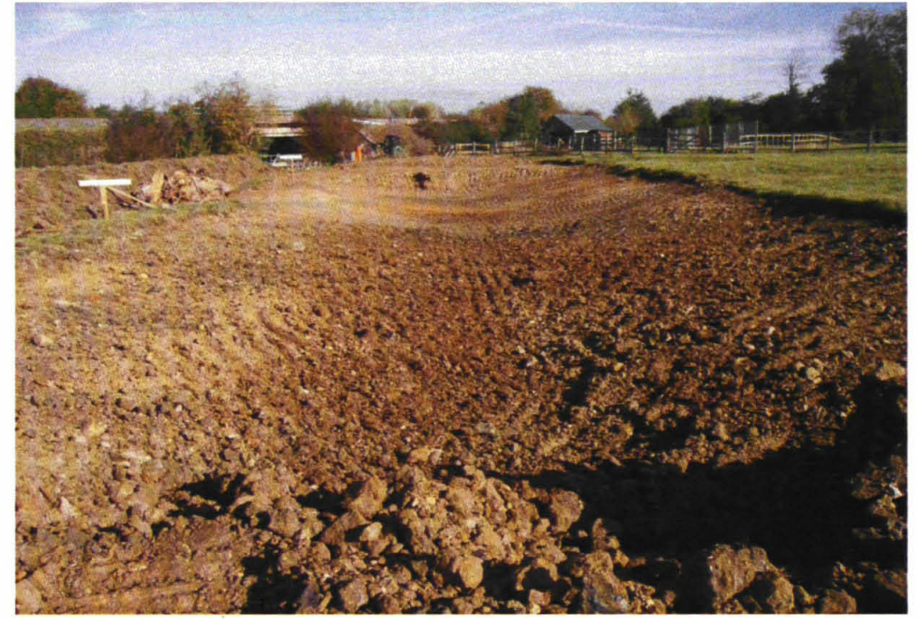
28) 027.jpg Fall profile of swale → NE
