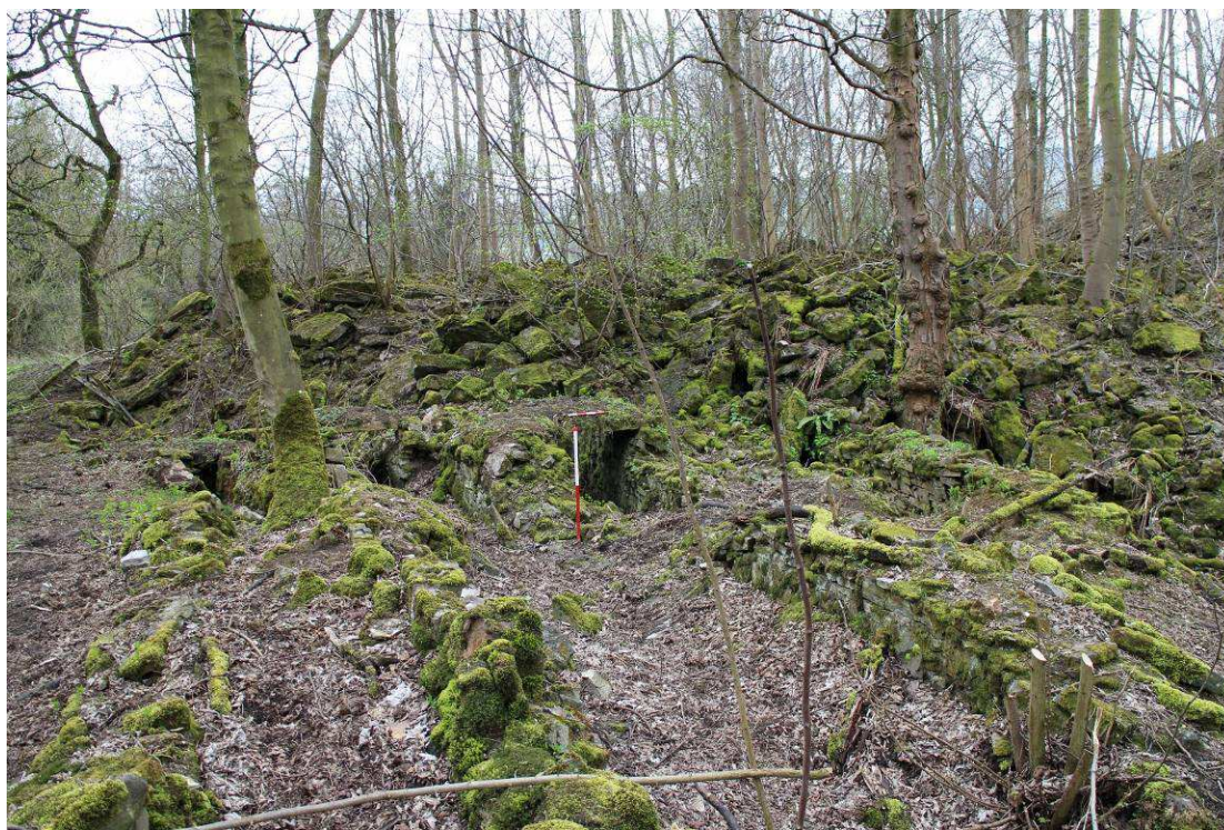
Plate 37: Flue-terminals 6g.1 , 6g.2 and 6g.3 looking south
