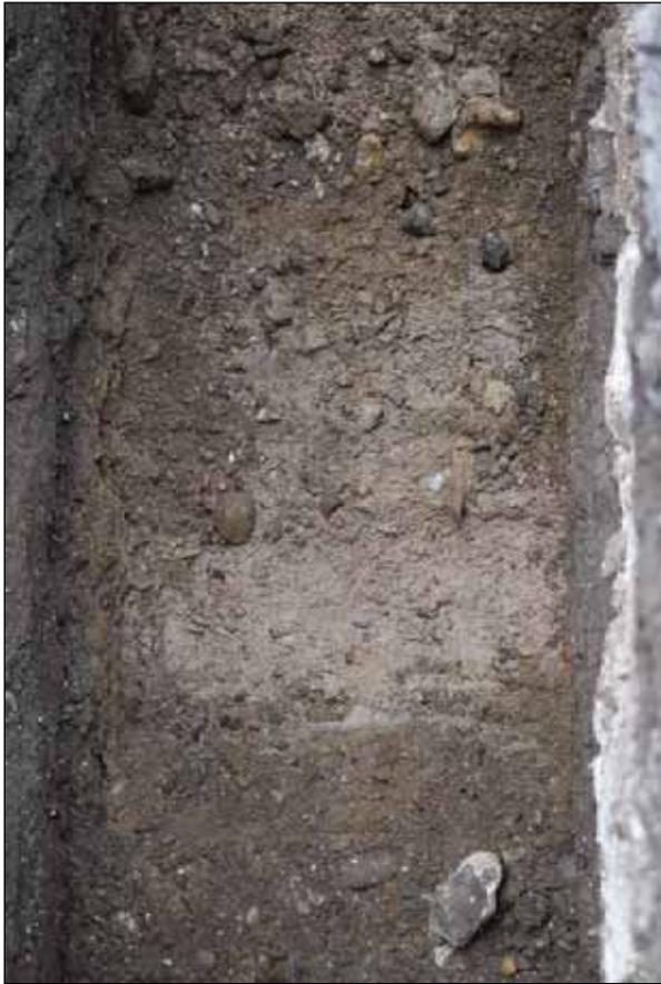
Plate 21: Lime rich mortar layer 127 *in situ*
