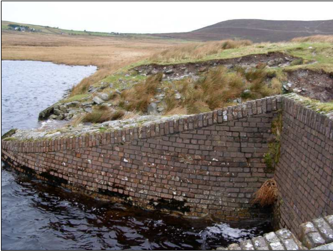
Plate 9: Llyn y Mynydd dam (NMR 270092)
