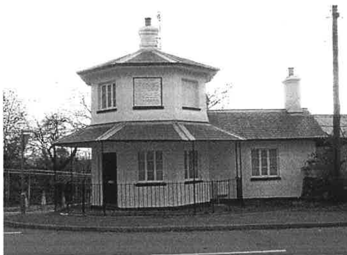
Plate 26 Llanfair PG tollhouse (Site 197)
