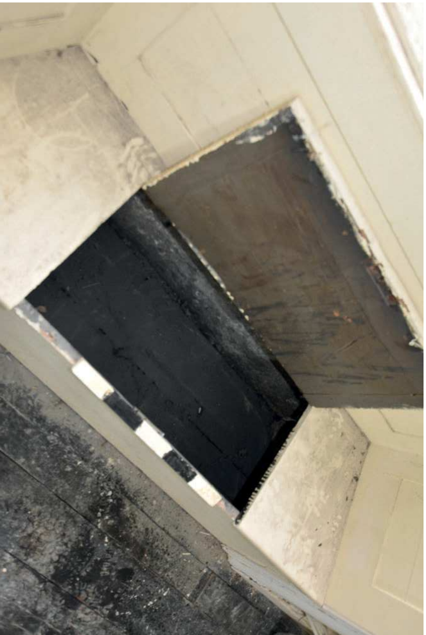
Plate 54: Coal bunker seat in Room F1
