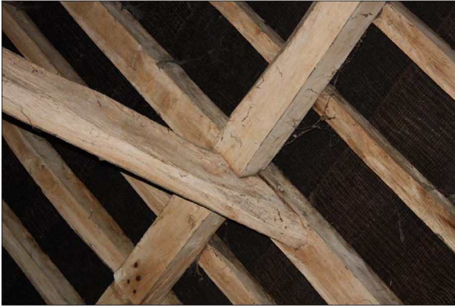
Plate 35: Detail of clasped purlin , F1
