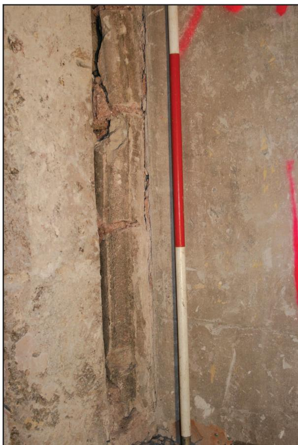
Cliché 72 : Pierre de taille réutilisée dans une ouverture de fenêtre remodelée, 45P3
