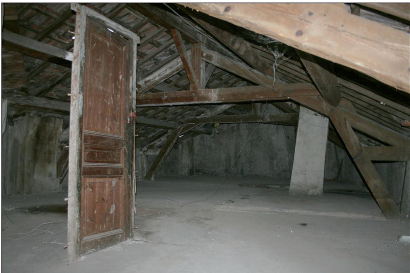
Cliché 132 : Encadrement de porte (cloison démolie), et vue de la charpente, 90T1
