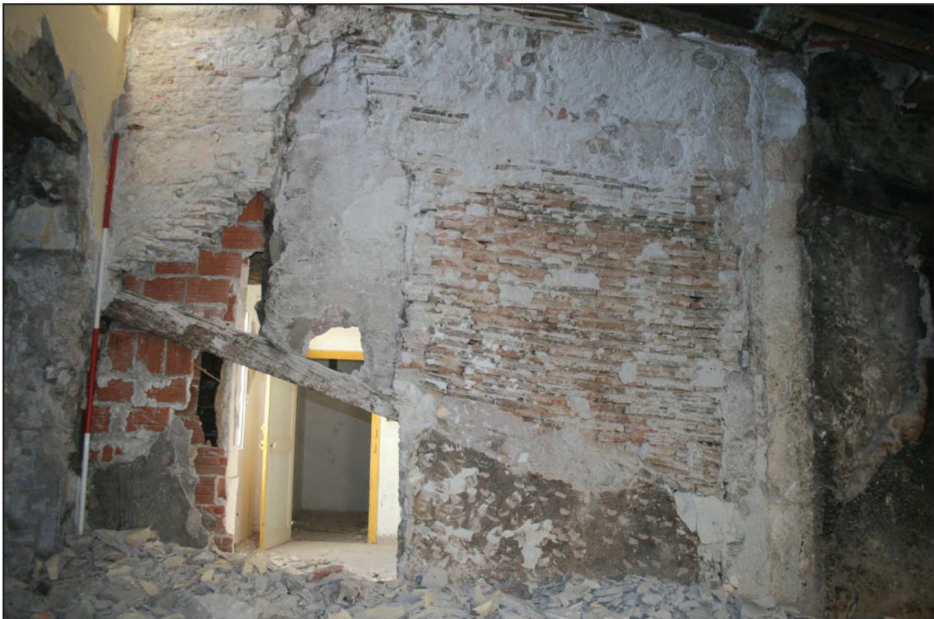
Cliché 109 : Mur sud monté en réutilisant des tuiles de toiture plate, 46T1, avec ouverture bouchée avec de l'enduit de plâtre
