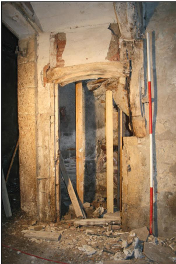
Cliché 3 : Passage de porte partiellement charpenté en bois sous un escalier, 19R1
