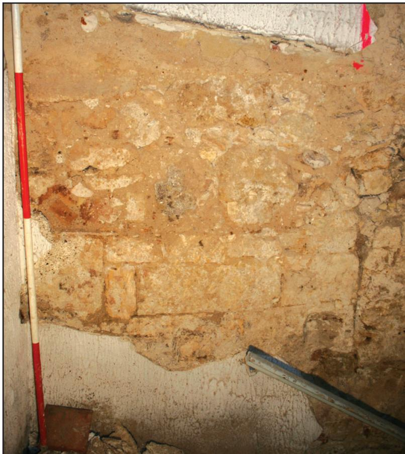
Cliché 5 : Mur en pierre de taille situé sous une élévation de blocaille, cage d'escalier 19R1
