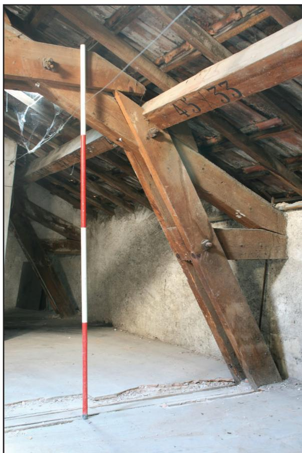
Cliché 136 : Poutre transversale dans le plancher, et détail d'assemblage de la charpente, 90T1
