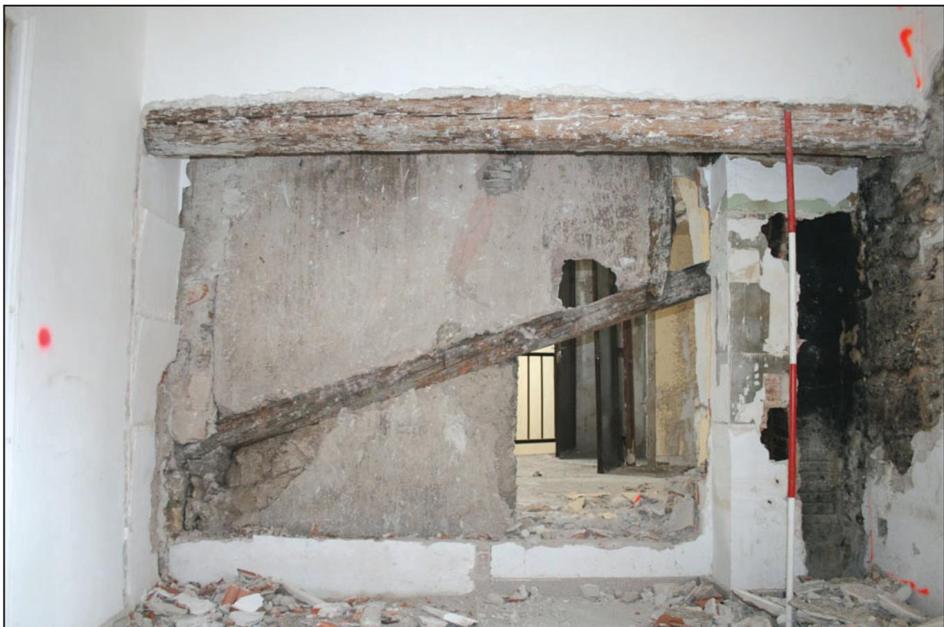
Cliché 91 : Cloison en pan de bois et mortier de chaux, mur nord 45T2
