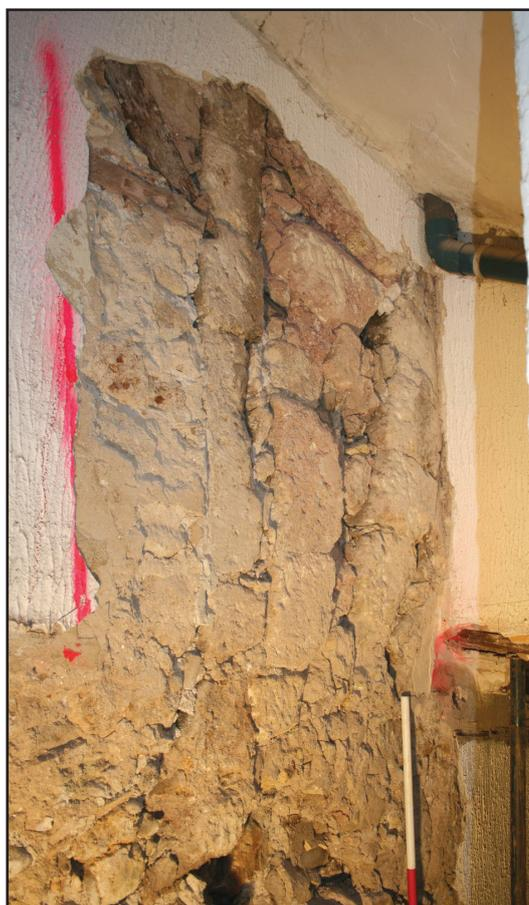
Cliché 4 : Blocage avec des éléments en pierre de taille d'un arc (droite) et remodelage postérieur 19R1
