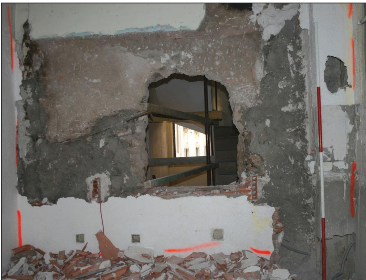
Cliché 84 : Remplissage de cloison en pan de bois, mur nord, 45D2
