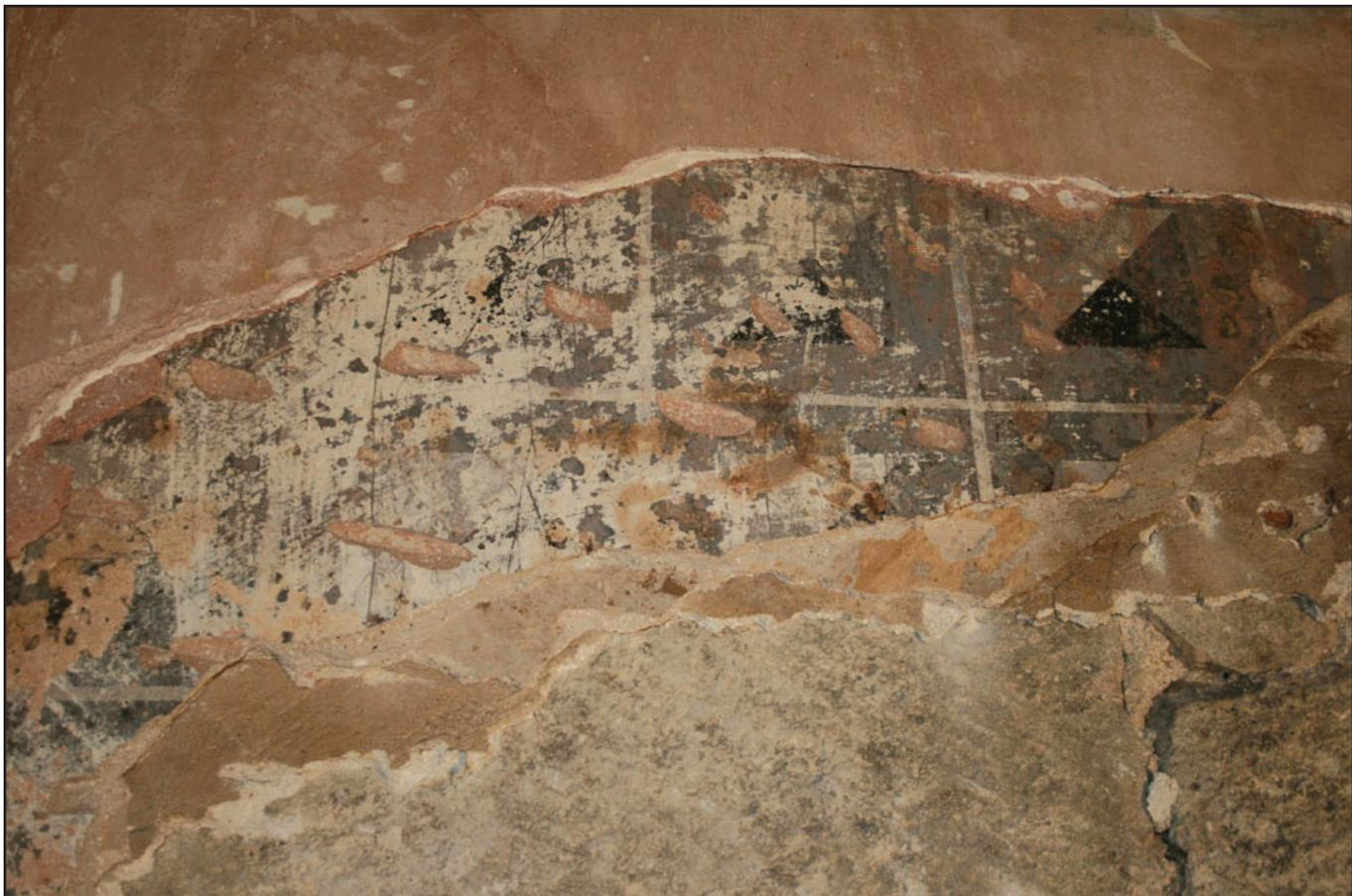
Cliché 63 : Détail des différentes couches d'enduit de plâtre, mur nord 45P1
